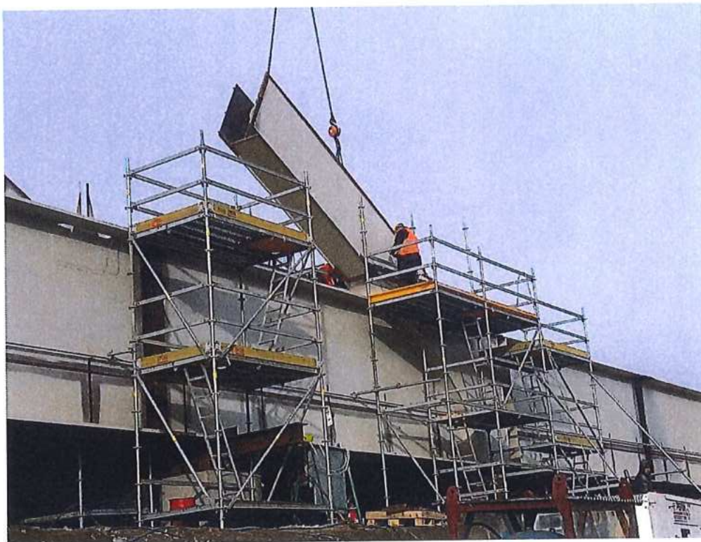
Montáž oceľovej konštrukcie mosta – SO 12-33-04
