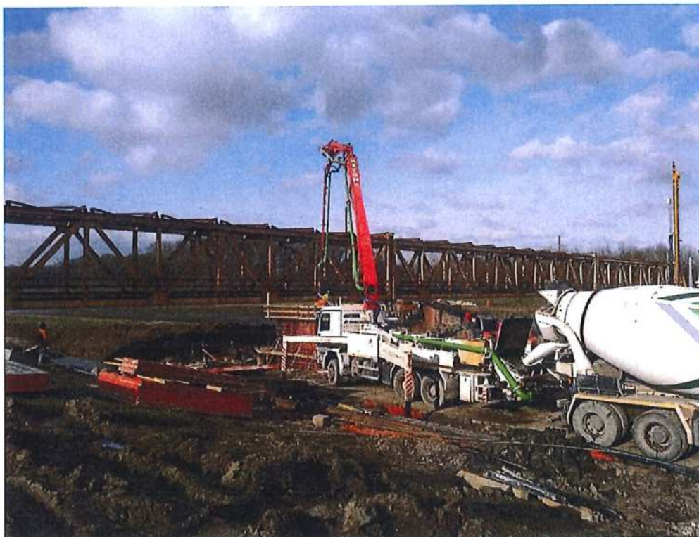
Betonáž piliera P1 na SK strane - SO 12-33-04
