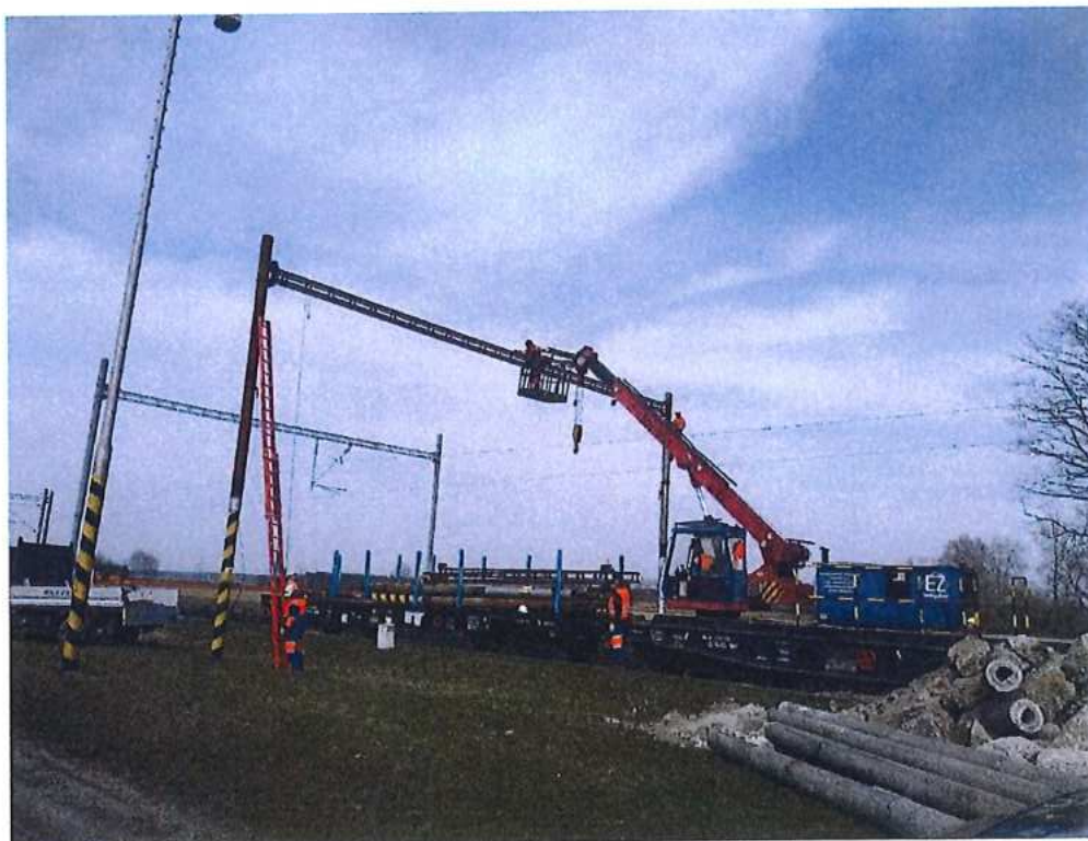
Demontáž trakčných brán ( zast.Brodské ) - SO 11-35-01
