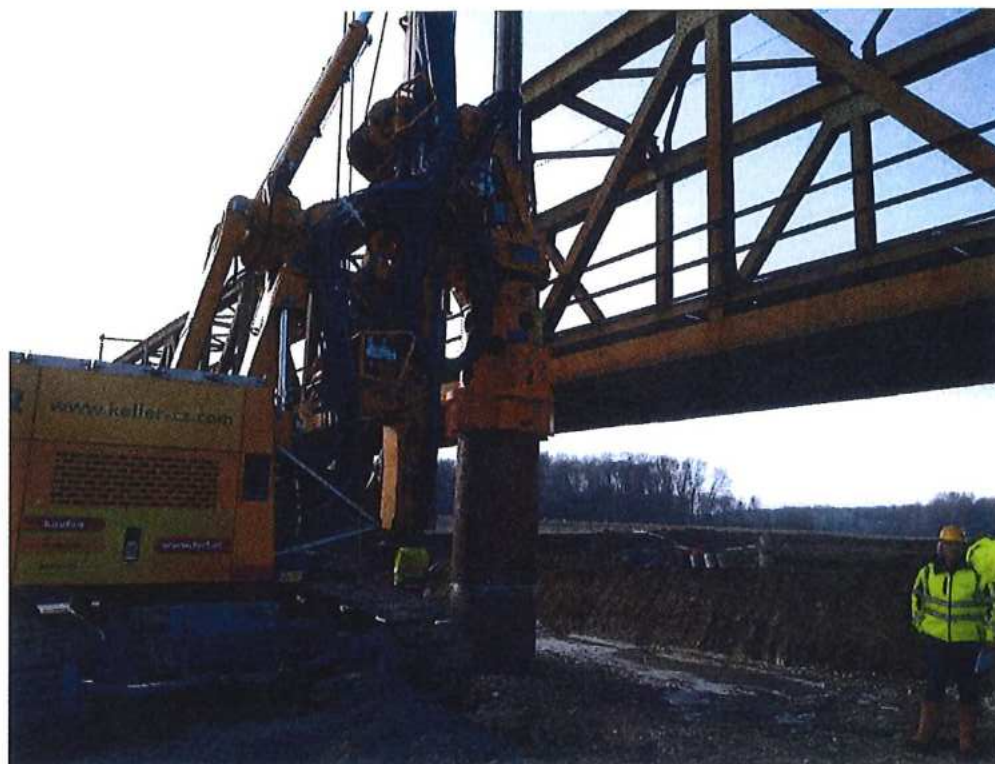
Vŕtanie a betonáž pilót - pilier P2 na strane CZ - SO 12-33-04
