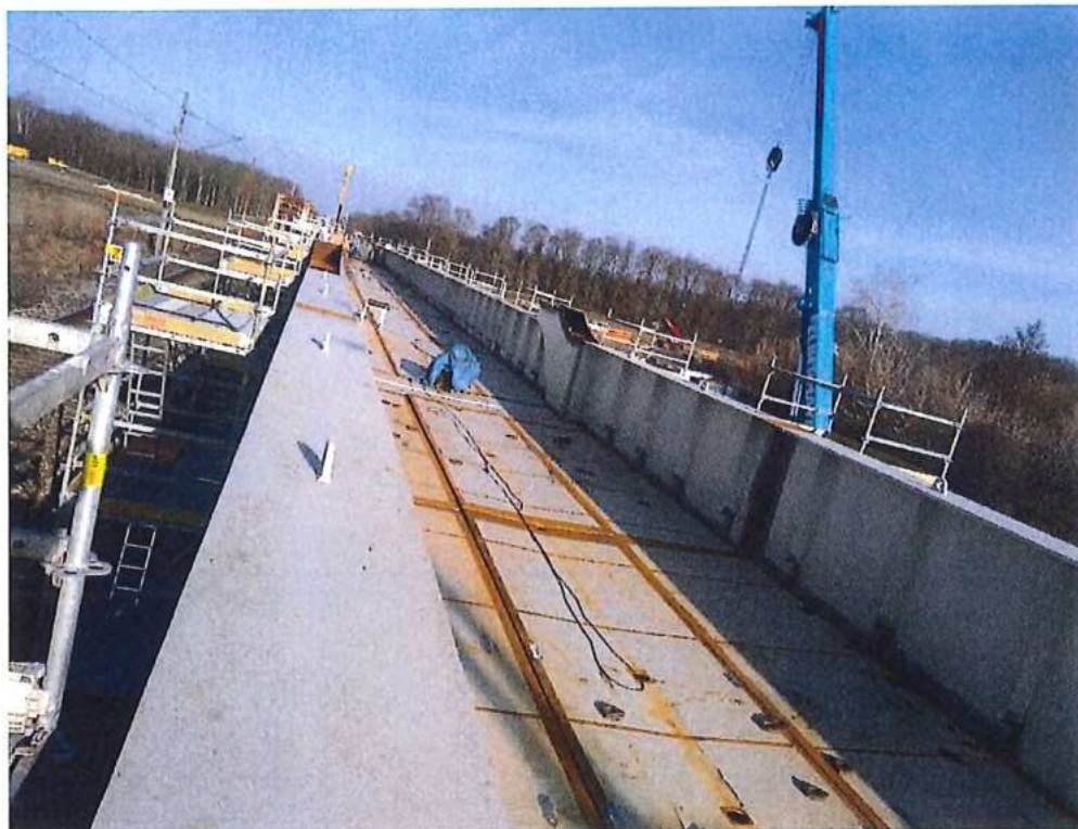
Montáž oceľovej konštrukcie mosta – SO 12-33-04
