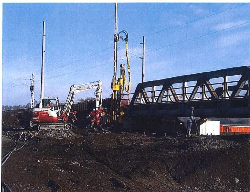
Trysková injektáž opory mosta – SO 12-33-02
