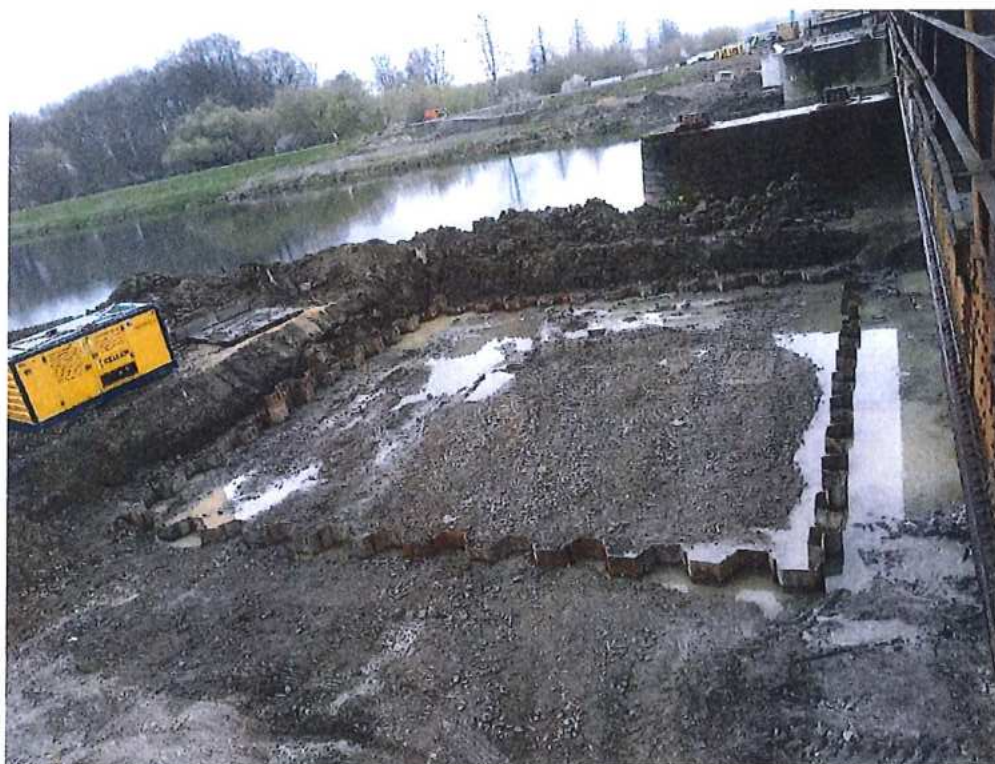
Ukončené baranenie štetovnic pri pilieri P2 na strane CZ – SO 12-33-04
