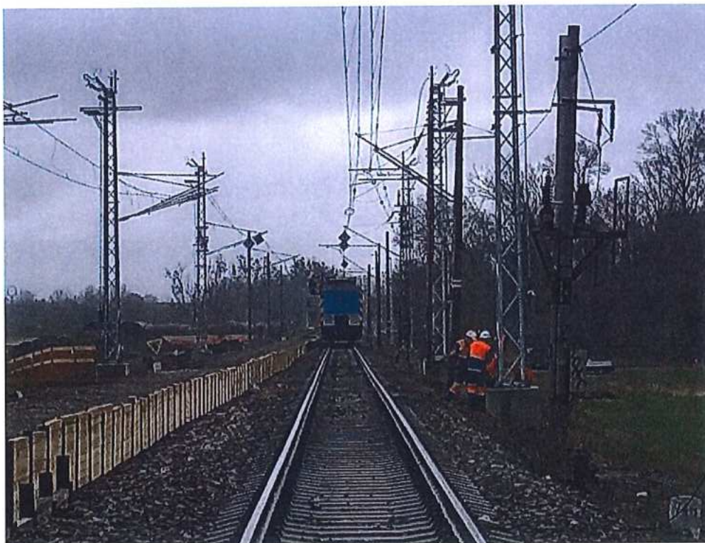
Stavanie trakčných stožiarov pri 2.TK v km 73,850 – 74,200
