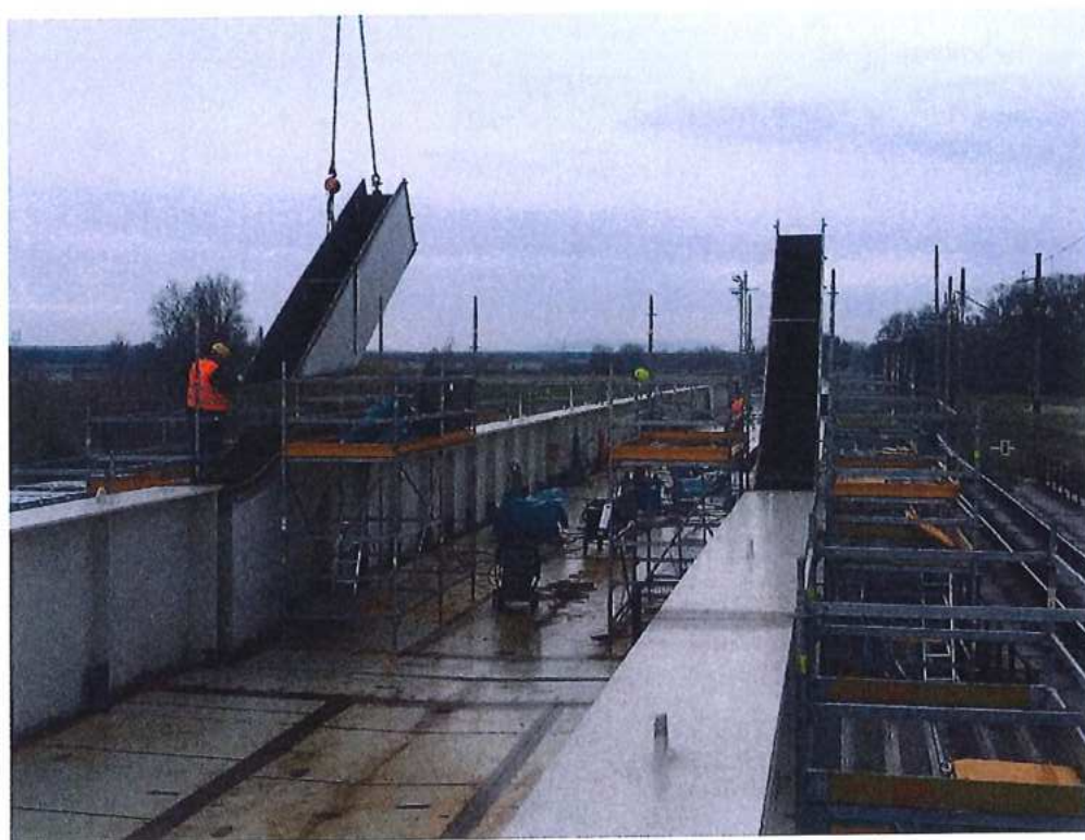
Montáž oceľovej konštrukcie mosta – SO 12-33-04
