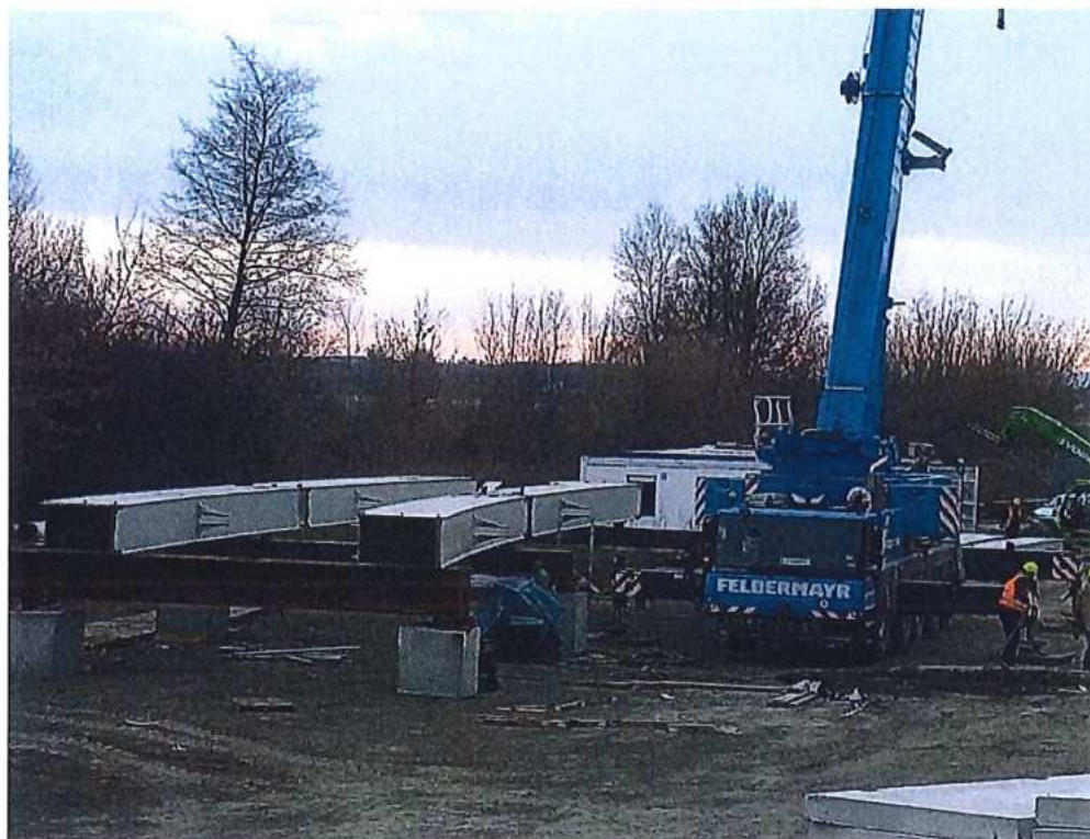
Montáž ocelejovej konštrukcie mosta - SO 12-33-04
