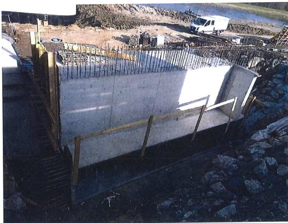
Betonáž a oddebnenie opory OP1 - SO 12-33-04
