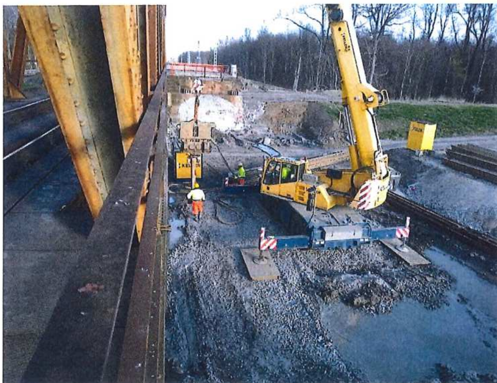
Baranenie štetovnic pri pilieri P2 na strane CZ – SO 12-33-04
