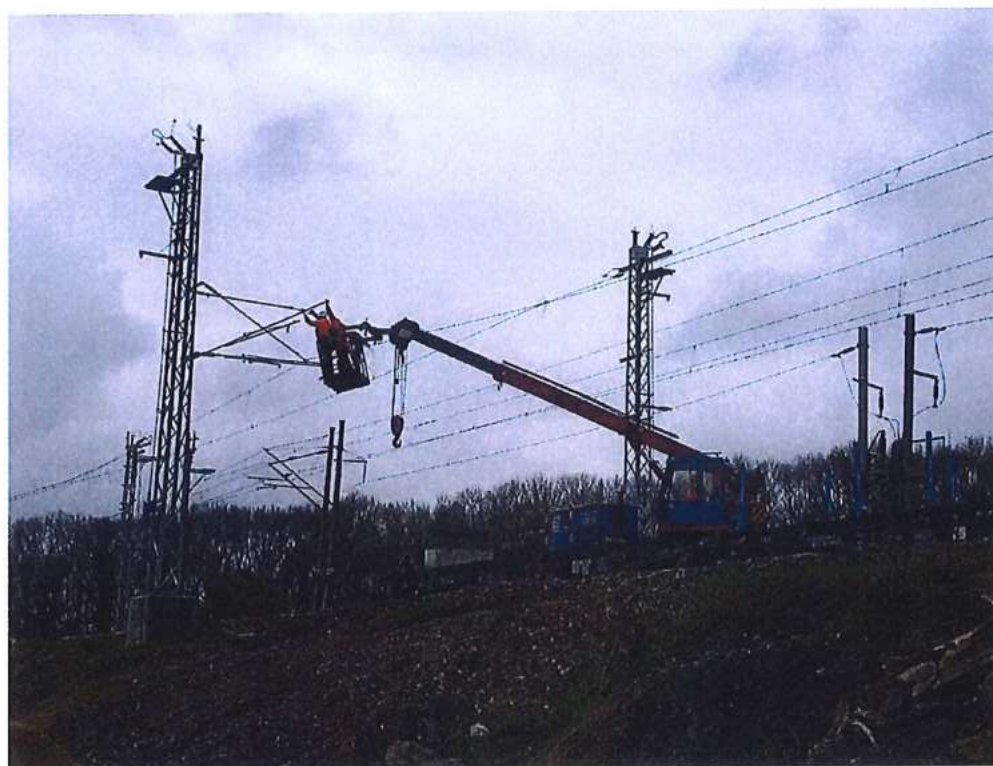
Stavanie trakčných stožiarov pri 2.TK v km 73,850 – 74,200
