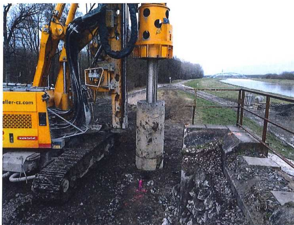
Vŕtanie pilót pri opore na CZ strane - SO 12-33-04
