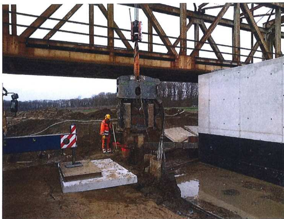
Demontáž štetovnicovej steny pri pilieri P1 SK strana – SO 12-33-04
