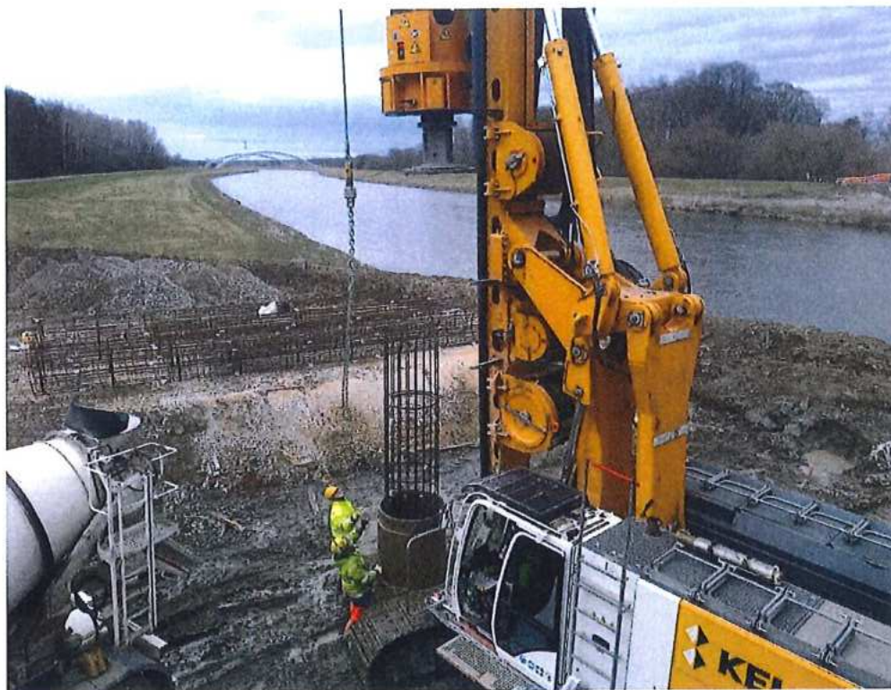
Vŕtanie a betonáž pilót na pilier P2 na strane CZ – SO 12-33-04
