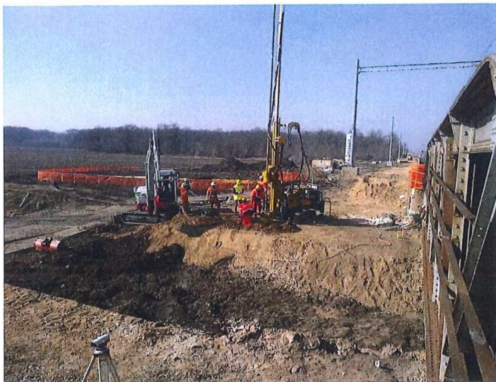
Príprava na tryskovú injektáž - SO 12-33-01
