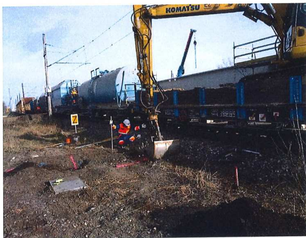
Výkop a betonáž základov TP - SO 12-35-01
