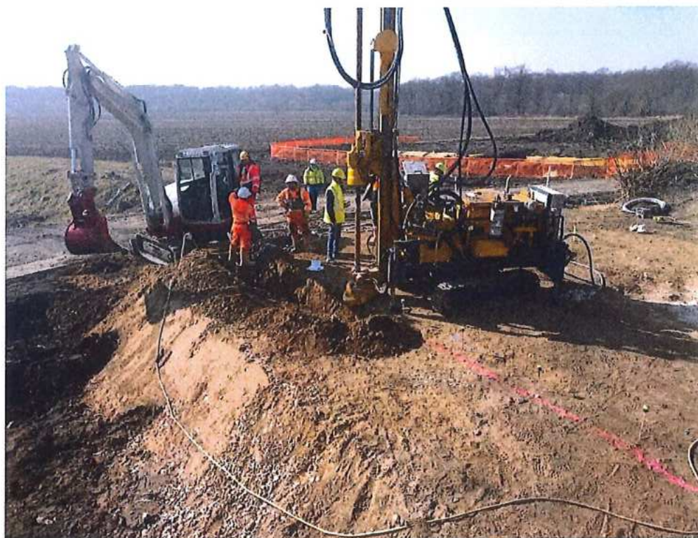
Trysková injektáž opory mosta – SO 12-33-01
