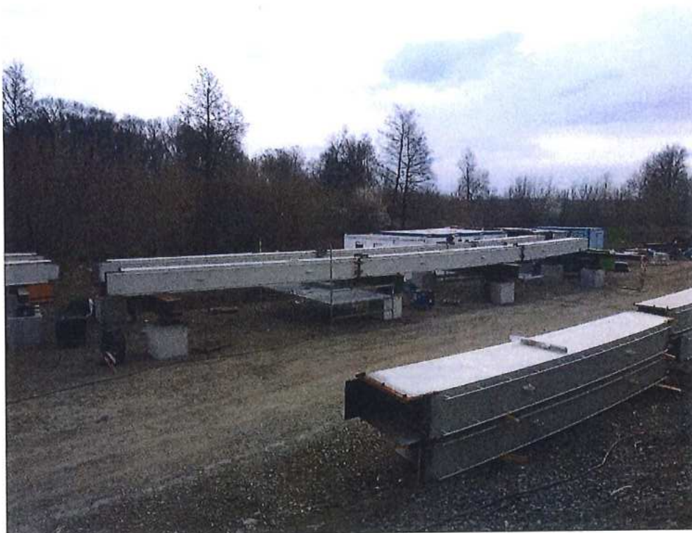
Predmontáž oblúkov mosta na pomocnej platforme – SO 12-33-04
