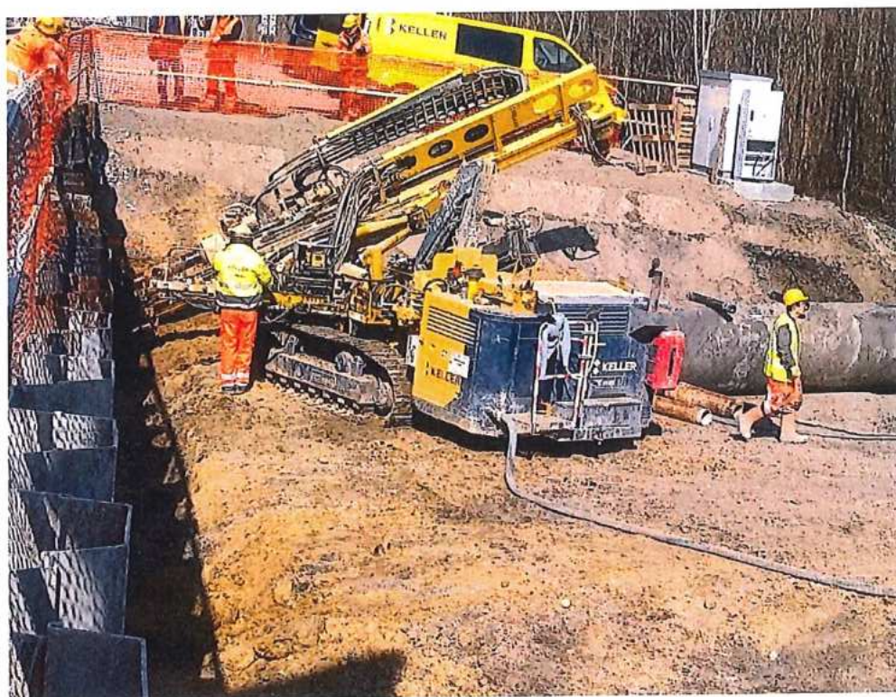
Vítanie kotiev pre stabilizáciu lasrsenovej steny – SO 12-33-05
